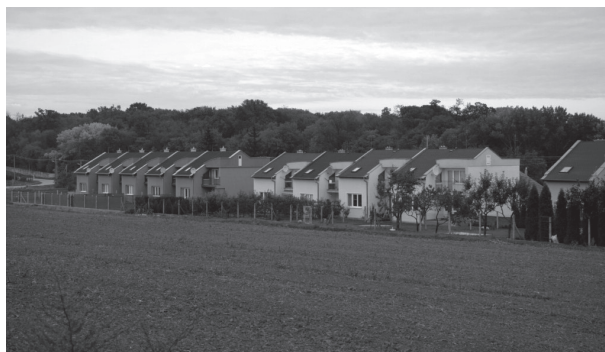
Obr. 4. Nová radová výstavba na okraji obce (Veľké Zálužie, 2011). Foto: Roberta Štěpánková
