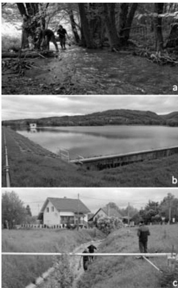
Obr. 2. Umelá vodná nádrž Kuchyňa (a – prítok, b – nádrž, c – odtok)
