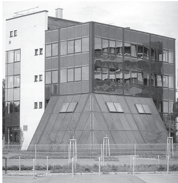
12. Administratívna budova v Troisdorfe
