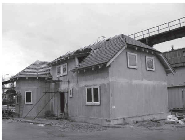
1. Pohľad na montáž energeticky pasívneho panelového domu IDA I. Foto: autor
