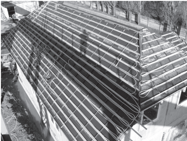
2. Realizácia energetickej strechy. Foto: autor
