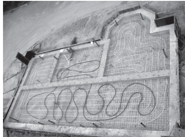
3. Okruhy v zemnom zásobníku tepla. Foto autor
