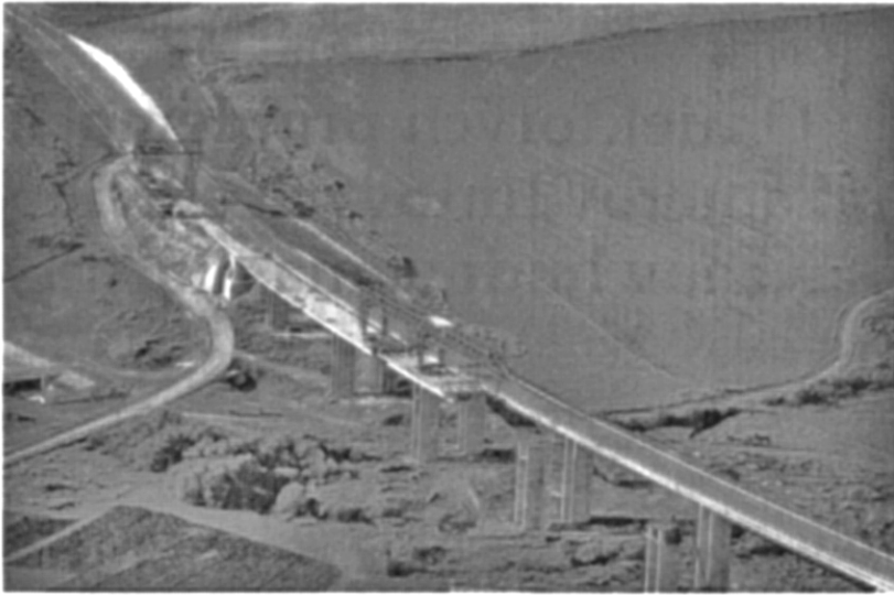
Diaľnica D 1 v úseku Liptovský Mikuláš – Hybe, most „Hybica“ (montáž)
