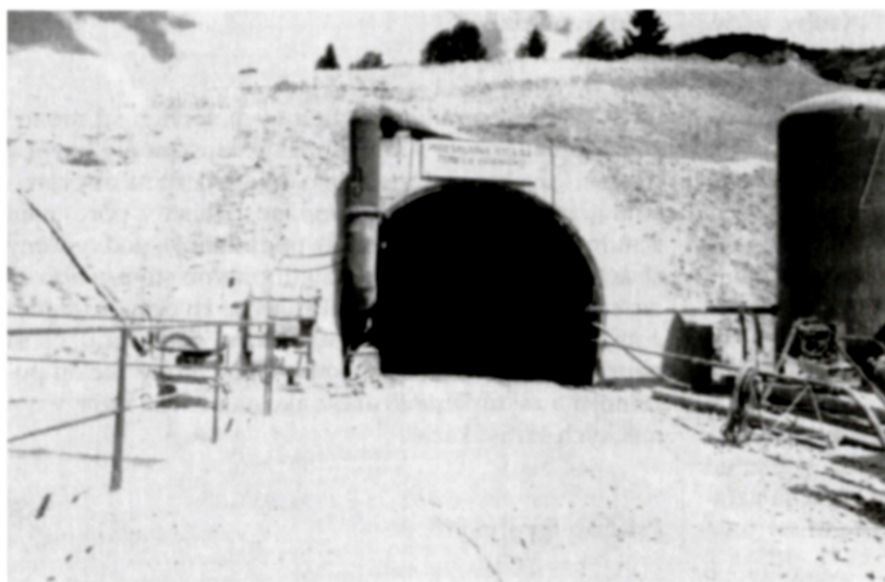
Diaľnica D 1 v úseku Behárovce – Branisko, výstavba prieskumnej štólne
